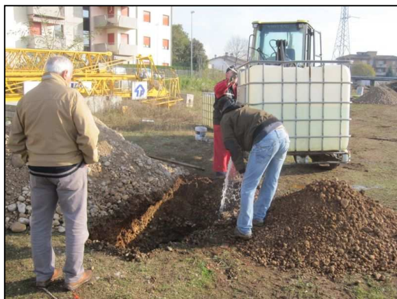
Approntamento della prova di carico
