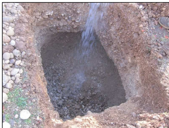
Tentato riempimento della sezione di scavo
